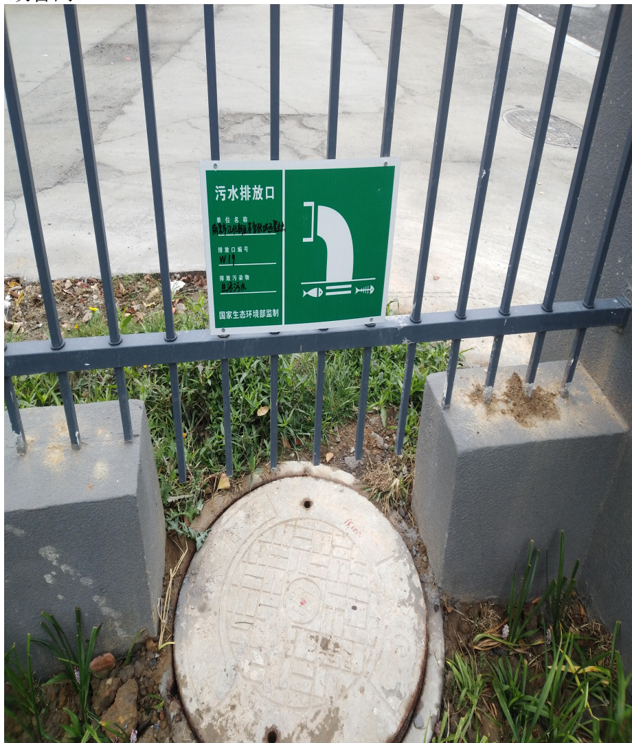
污水总排口标识牌
