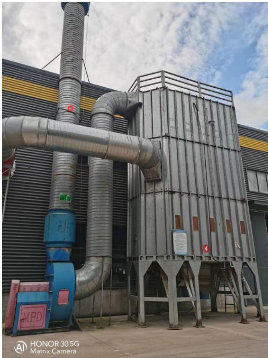
2#车间仿古刨废气处理设施 DA005 排气筒
