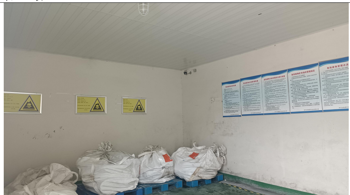
危废库地面防渗、分类分区及防爆灯、视频监控及危废管理制度
