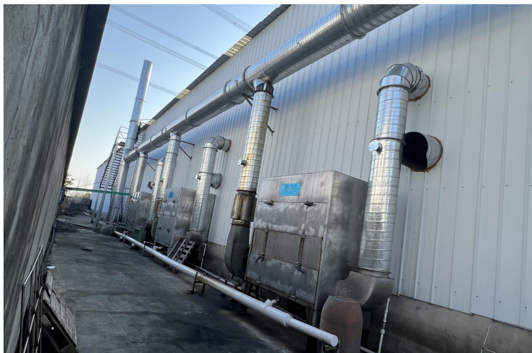
3 台团粒机及上方废气集气罩
