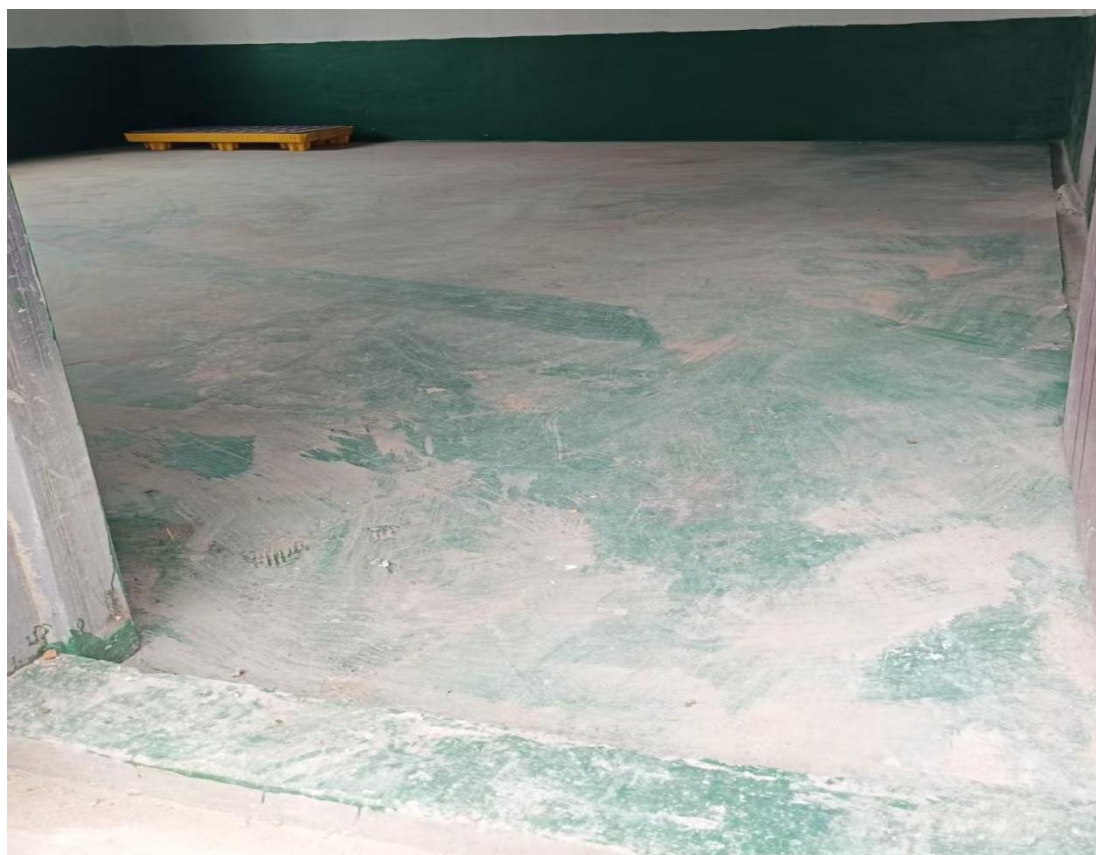
危废库内外部图片
